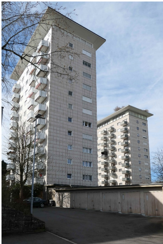
Ansicht von Südosten, Hochhaus «Gyrhalde» vorne (2020)
