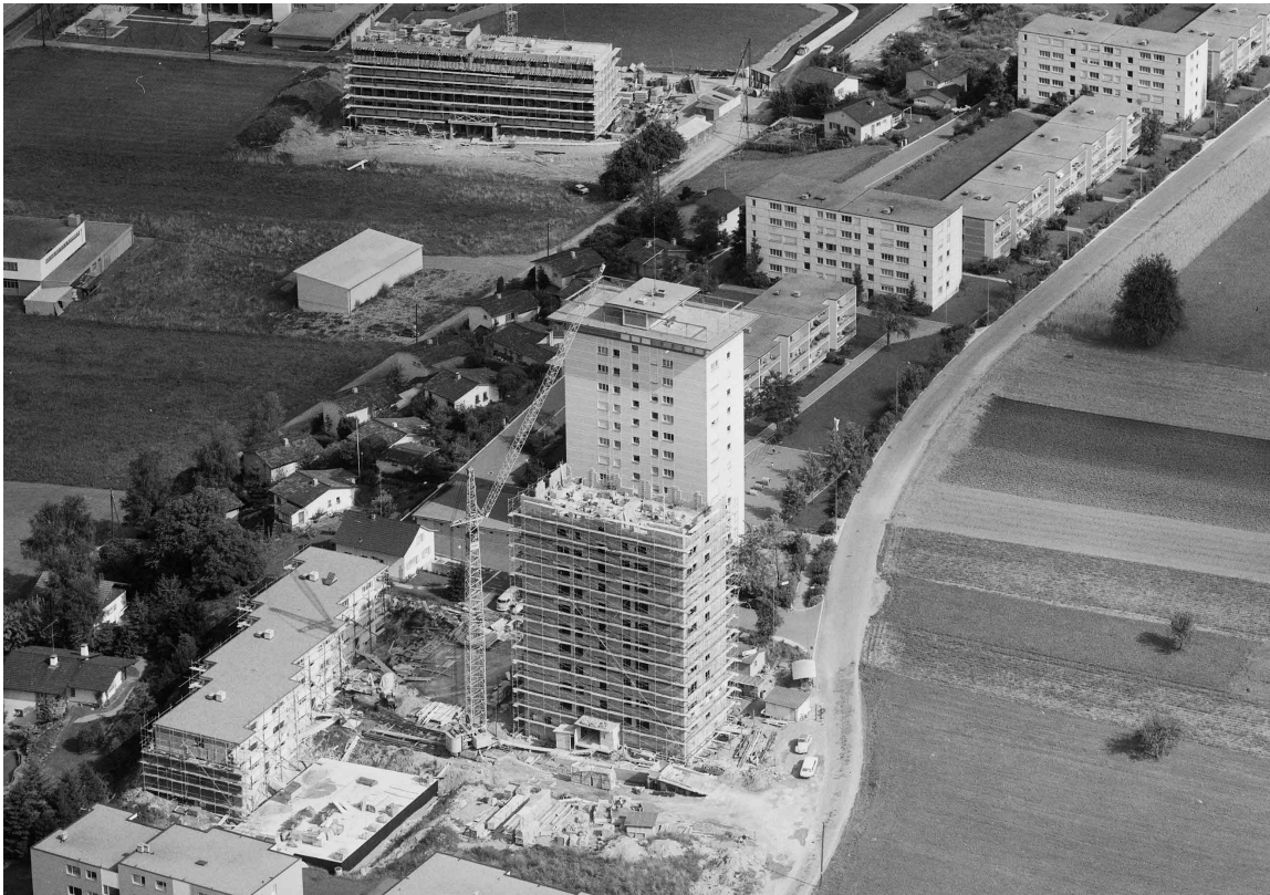
Flugaufnahme von Nordwesten während des Baus, 1966 (ETH-Bildarchiv, Com_F66-08339, Ausschnitt)
