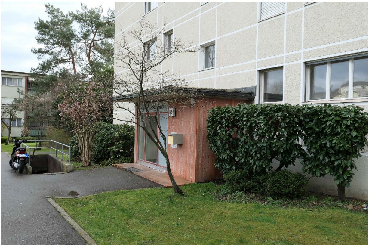
Eingangsvorbau mit roter Travertinverkleidung an der Nordfassade (2020)
