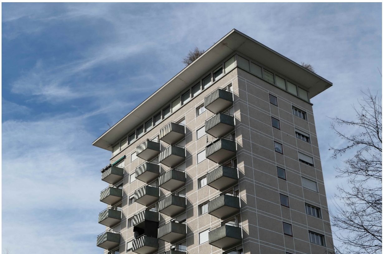
Oberste Geschosse und Flugdachabschluss von Südosten (2020)
