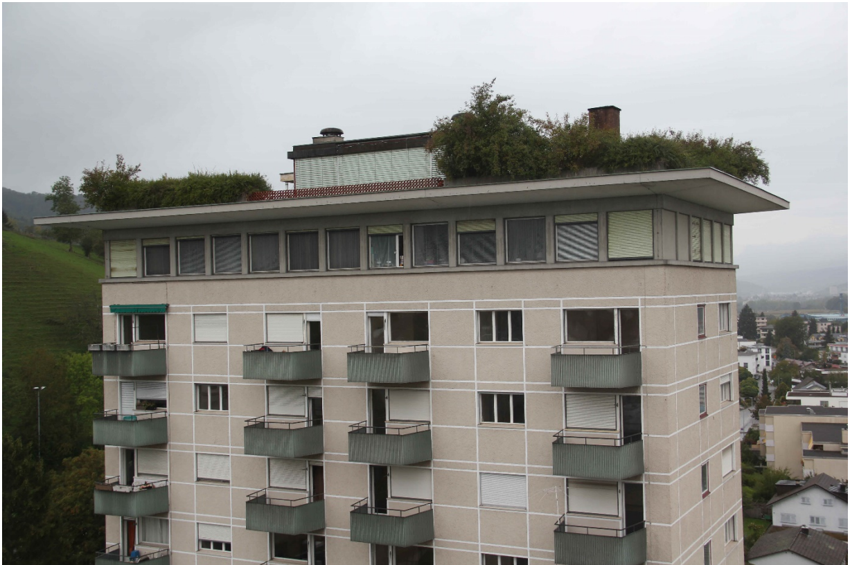
Detail des Dachabschlusses samt Terrasse und Dachaufbau (2020)
