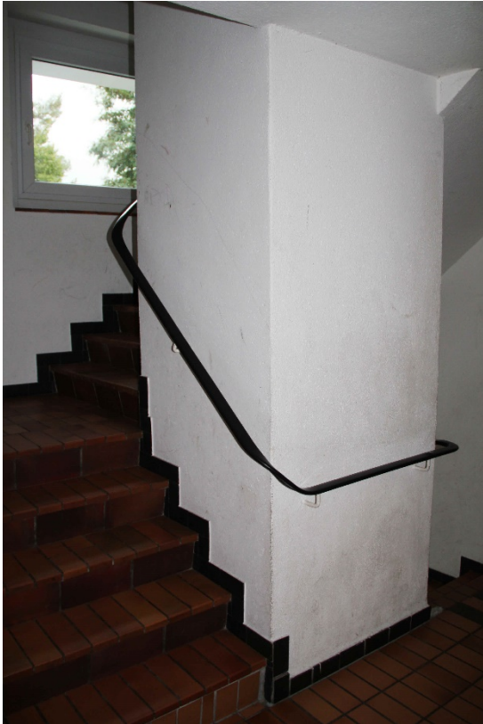
Treppenhaus mit tragendem Mauerpfeiler (2020)
