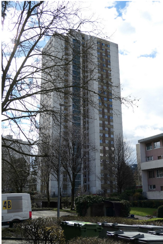
Langäckerstrasse 15, Punkthochhaus, Nordwestfassade (2020)
