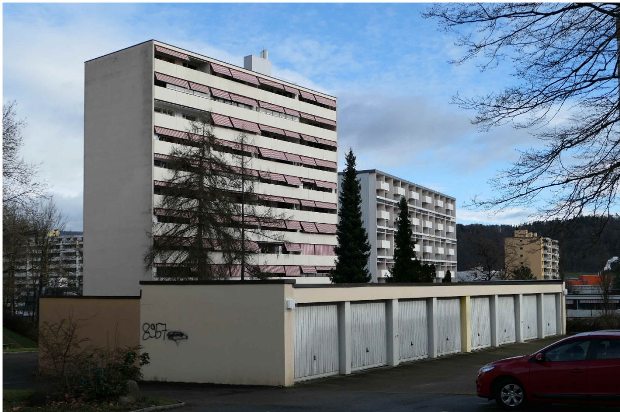
Bahnhofstrasse 59 (vorne) und 68 (2020)
