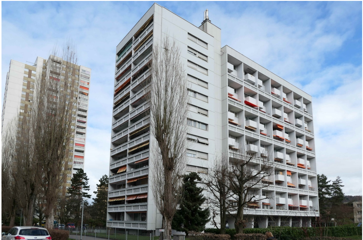
Langäckerstrasse 32, «casabella», von Süden (2020)
