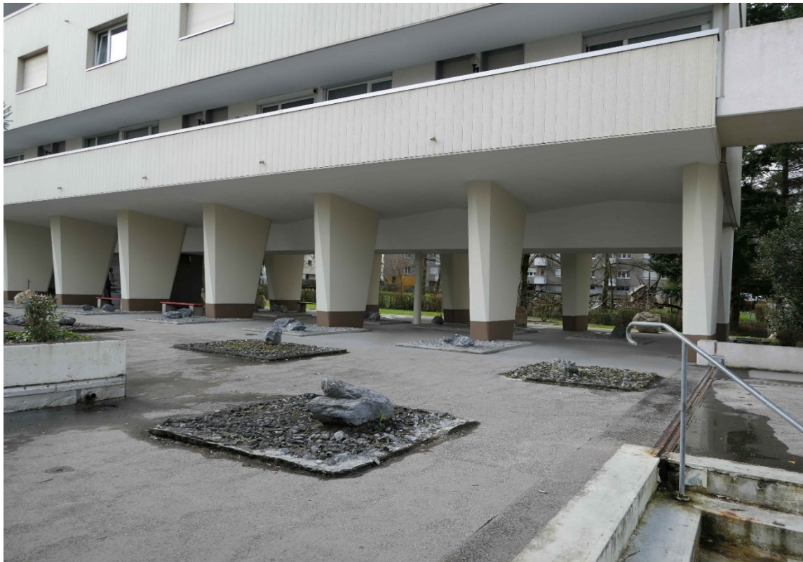
Langäckerstrasse 28, «bellavista», offenes Pfeilergeschoss (2020)
