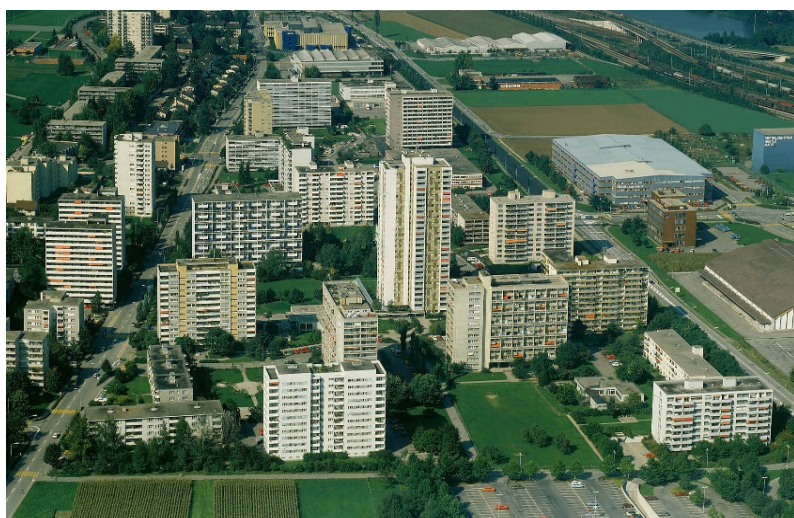
Luftbild von Südosten, 1982 (ETH-Bibliothek Zürich)
