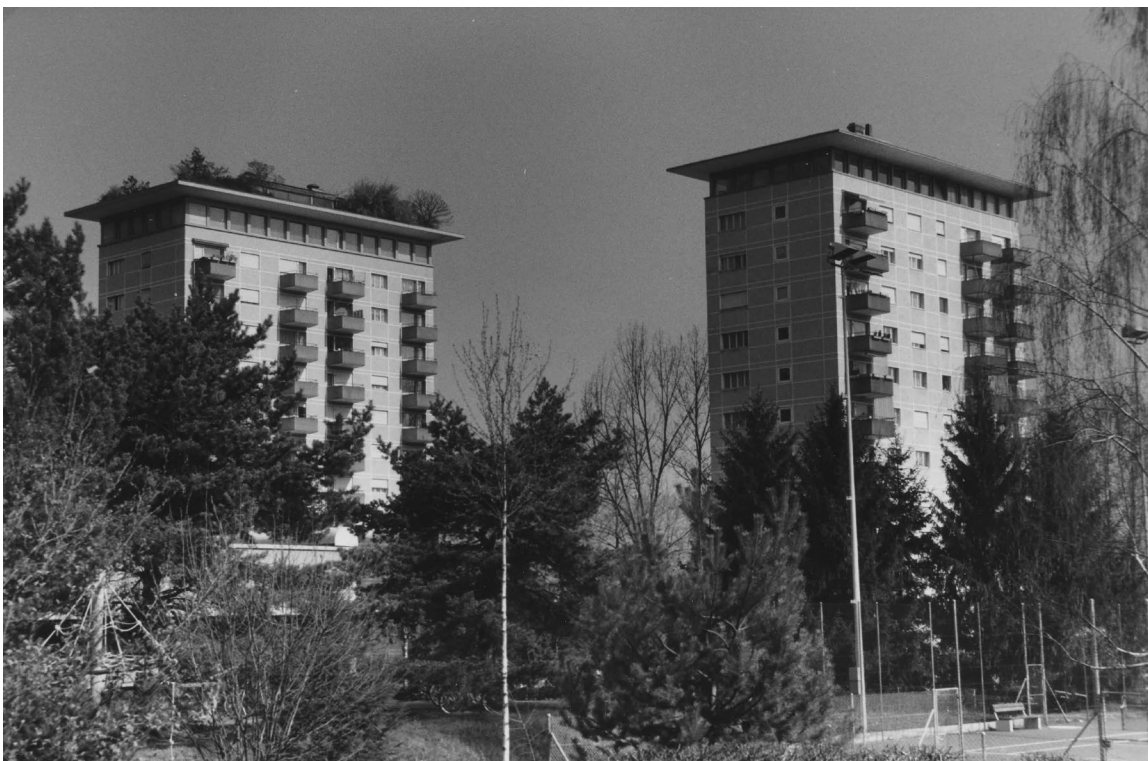
Ansicht der beiden Hochhäuser von Südwesten vor der Fassadenrenovation des Hochhauses «Gyrhalde», 1991 (Fotosammlung Denkmalpflege)
