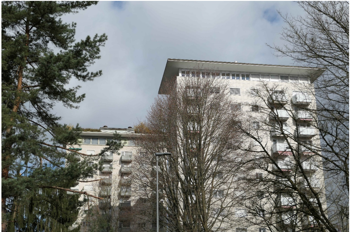
Dachabschluss mit Flugdach der beiden Hochhäuser, Haus «Gyrhalde» vorne (2020)
