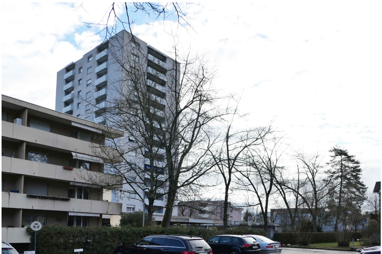
Glattlerweg 12 von Südwesten (2020)
