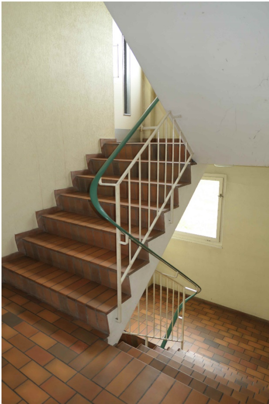
Treppe mit Belag aus Terrakottaplatten und Metallgeländer (2020)
