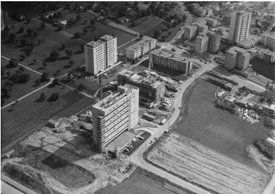
Baustellen der Hochhäuser «casabella» und «bellavista» und fertiggestelltes Hochhaus «Rotzenbühl», 1966 (ETH-Bildarchiv, Com_F66-08343)
