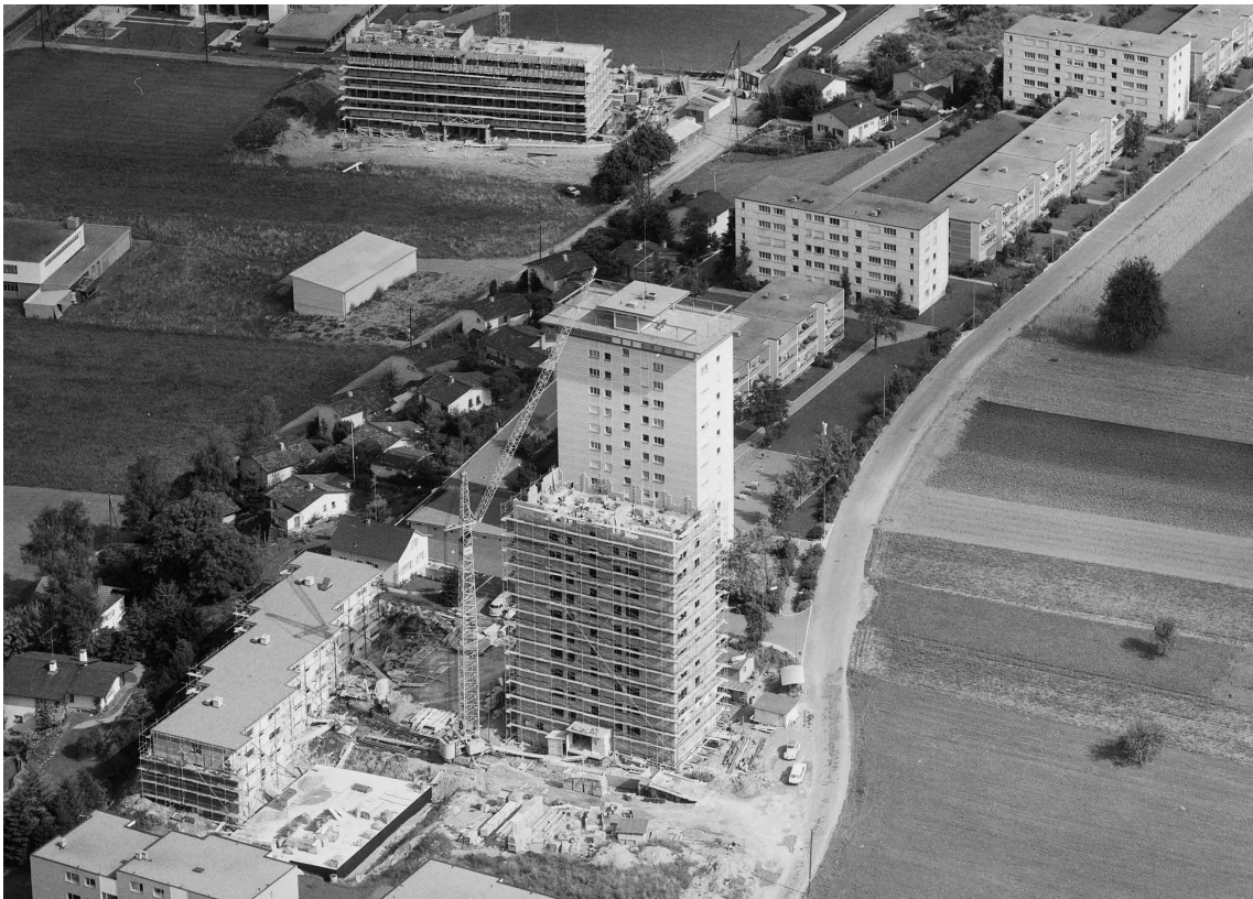
Flugaufnahme von Nordwesten während des Baus des Nachbarhochhauses «Buchbühl», 1966 (ETH-Bildarchiv, Com_F66-08339, Ausschnitt)
