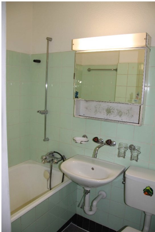
Badezimmer im bauzeitlichen Zustand (2020)
