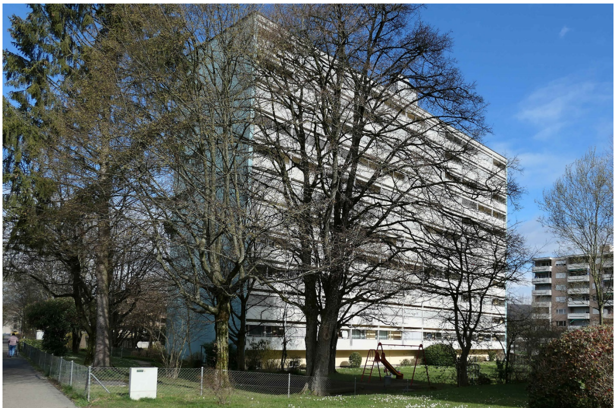
Bahnhofstrasse 100 von Südosten (2020)
