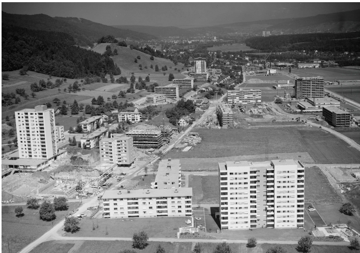
Baustellen im Langäckerquartier, Zustand 1964 (ETH-Bildarchiv, Com_F64-02650)
