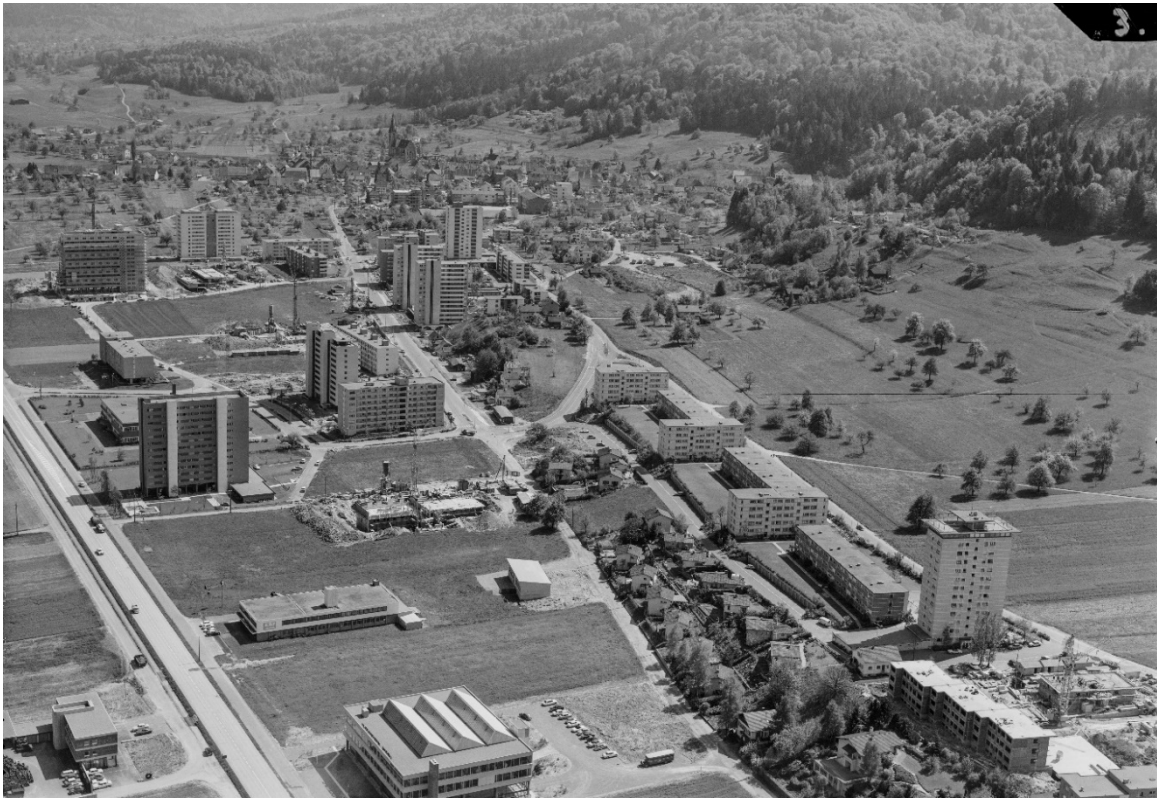
Baustellen im Langäckerquartier, Zustand 1966 (ETH-Bildarchiv, Com_F66-07513)
