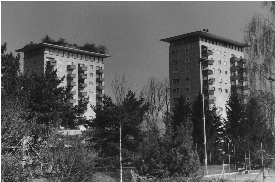
Ansicht der beiden Hochhäuser von Südwesten vor der Fassadenrenovierung mit Aussenwärmesdämmung, 1991 (Fotosammlung Denkmalpflege)
