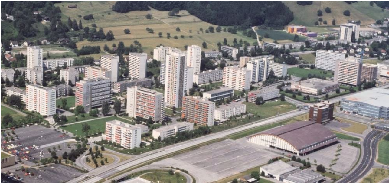
Abbildung 9: Quartier «Langäcker» in bauzeitlicher Farbgebung, Ansicht von Südosten, Vergrößerung aus Luftaufnahme von 1976 (Quelle: ETH-Bildarchiv, LBS_L1-769554, Ausschnitt).
