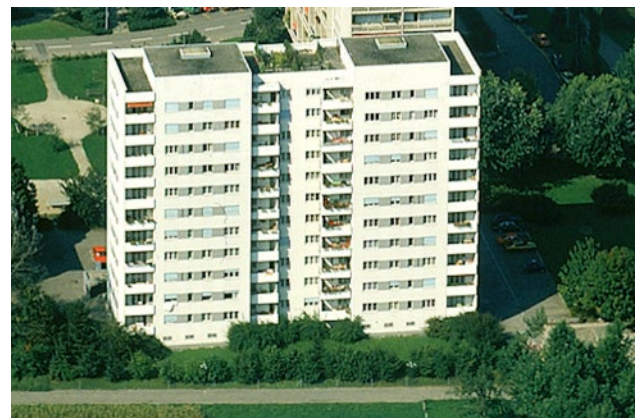
Abbildung 15: Bahnhofstrasse 56-58 mit bauzeitlicher Farbgebung, Vergrößerung aus Luftaufnahme von 1982 (Quelle: ETH-Bildarchiv, Com_FC01-8957-074, Ausschnitt).
