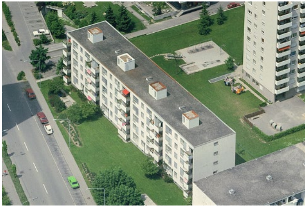
Abbildung 12: Bahnhofstrasse 74-80 mit bauzeitlicher Farbgebung, Vergrößerung aus Luftaufnahme von 1977 (Quelle: ETH-Bildarchiv, Com_FC01-8957-044, Ausschnitt).
