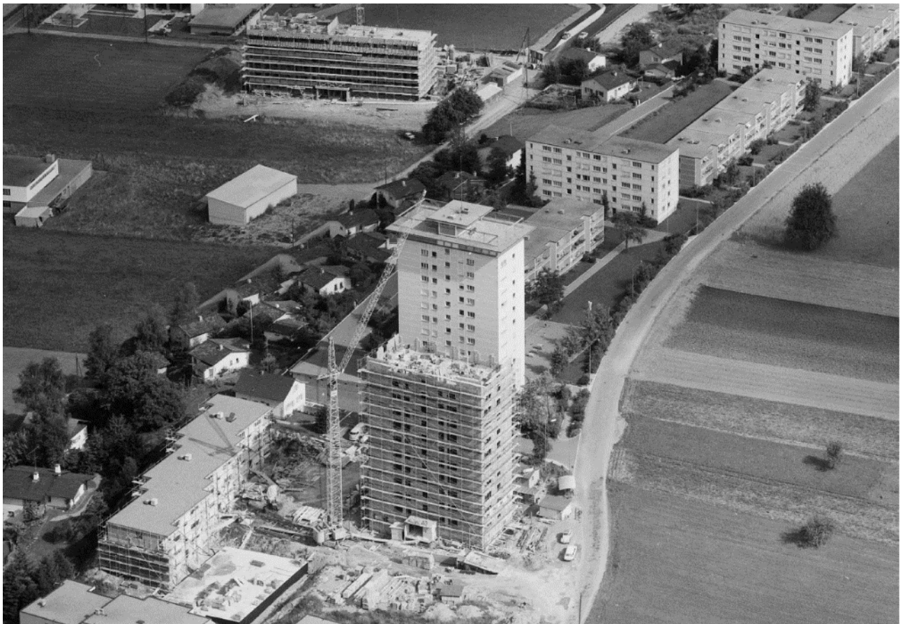
Abbildung 4: Flugaufnahme von Nordwesten während des Baus des Hochhauses «Buchbühl», dahinter das vollendete Hochhaus «Gyrhalde» und die weiteren Wohnbauten gemäss dem Richtplan Gyrhalde aus dem Jahr 1966 (Quelle: ETH-Bildarchiv, Com_F66-08339, Ausschnitt).
