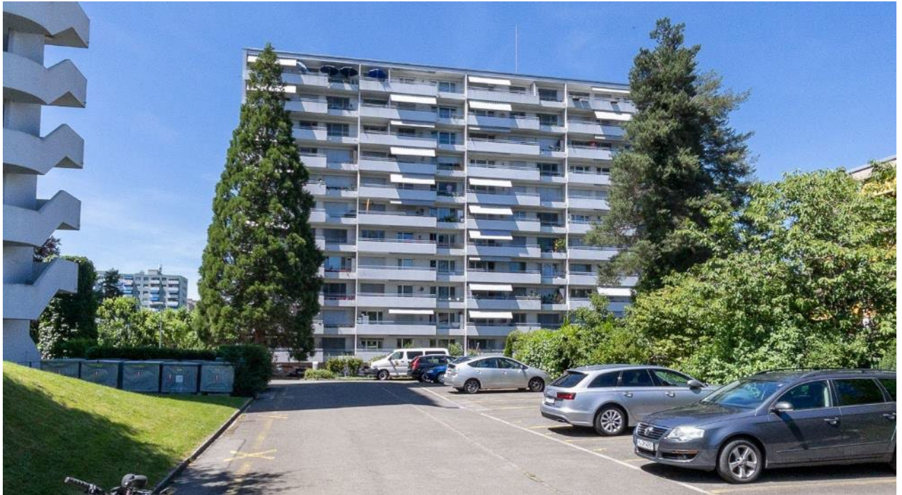
Abbildung 53: Mammutbäume und andere grosskronige Gehölze im Quartier bilden ein imposantes Gegenüber zu den mächtigen Gebäudevolumen (Quelle: Planung und Bau 2022).
