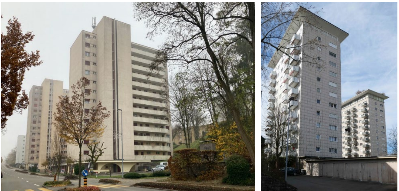
Abbildung 18: Zwei typische Beispiele für Ensembles; Links: Bahnhofstrasse 59/61; Rechts: Della Valle Hochhäuser Poststrasse 170 und 180 (Quelle: Denkmalwerkstatt 2022).
