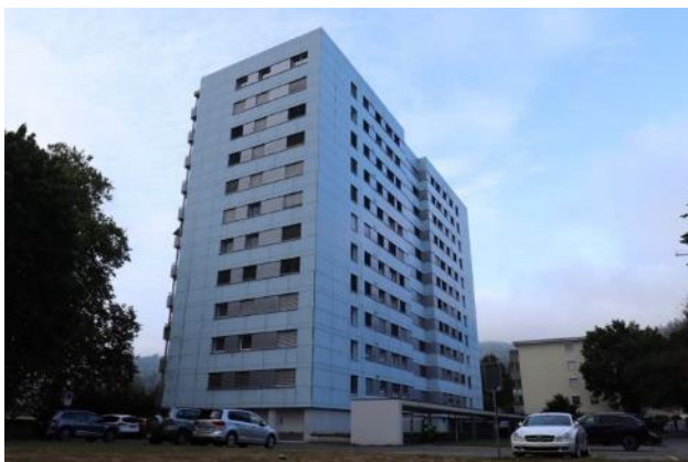
Abbildung 14: Bahnhofstrasse 56-58, 2022. Das Gebäude ist heute mit hellblauen Eternitplatten verkleidet, das Gebäude hat seinen bauzeitlichen Charakter verloren (Quelle: Denkmalwerkstatt 2022).
