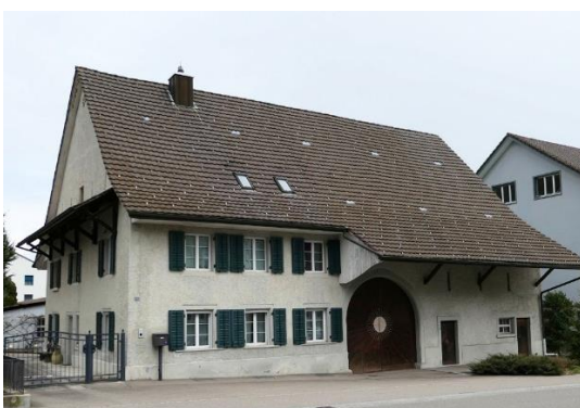
Zehntenhaus (Quelle: Bauinventar Denkmalpflege)
