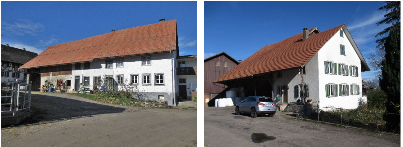
Abbildung 14: Die beiden Gebäude Heitersberg 4 (links) und Heitersberg 10 (rechts) sind zwar nicht inventarisiert, haben aber aufgrund ihrer Stellung und ihres Alters ebenfalls einen grossen Situationswert für den Weiler Heitersberg (Quelle: BV 2021)
